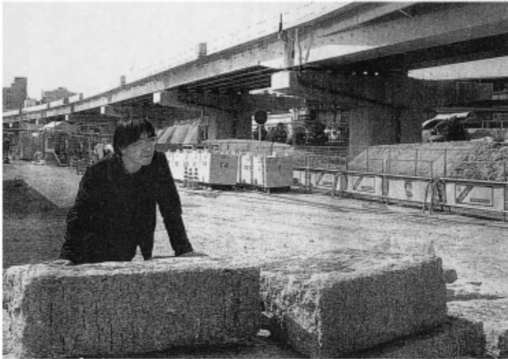
旧宇品線があった場所にて、建設中の道路の高架橋が延びる。そばにプラットホームの石が保存されていた（広島市南区宇品海岸で）
